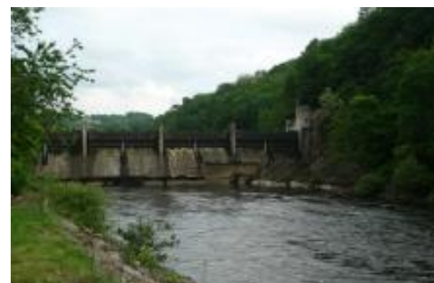
Barrage de la Roche-bât-l'Aigue
