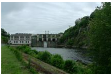
Barrage de La Roche au Moine
